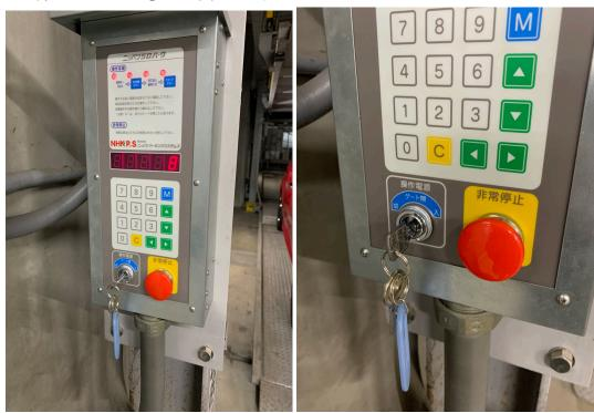
安全確認ボタン→呼び出し番号「NO.8」を押します→スタートボタンを押すとゲートがあき車が出せるようになります。
